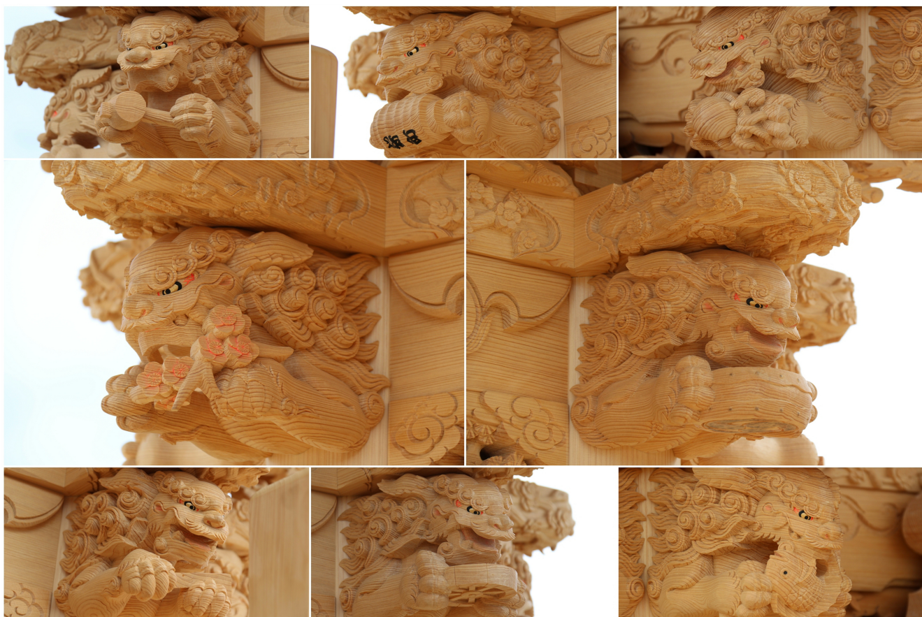
▲ 上段左:大屋根木鼻右面前:玄能を持つ唐獅子 ・ 上段中:大屋根木鼻左面後:弓張提灯を持つ唐獅子 上段右:大屋根木鼻後面左:蛸壺を持つ唐獅子 ・ 中段左:大屋根木鼻正面左:梅を持つ唐獅子 中段右:大屋根木鼻正面右:雷太鼓を持つ唐獅子 ・ 下段左:大屋根木鼻右面後:指矩を持つ唐獅子 下段中:大屋根木鼻左面前:コマを持つ唐獅子 ・ 下段右:大屋根木鼻後面右:鯛を持つ唐獅子
